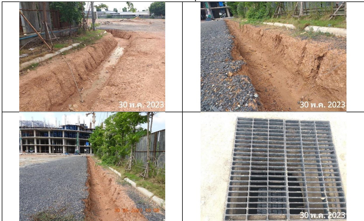
รูปที่ 2-11 รังดิน(ร่องระบายน้ำ) และบ่อดักตะกอนดิน
